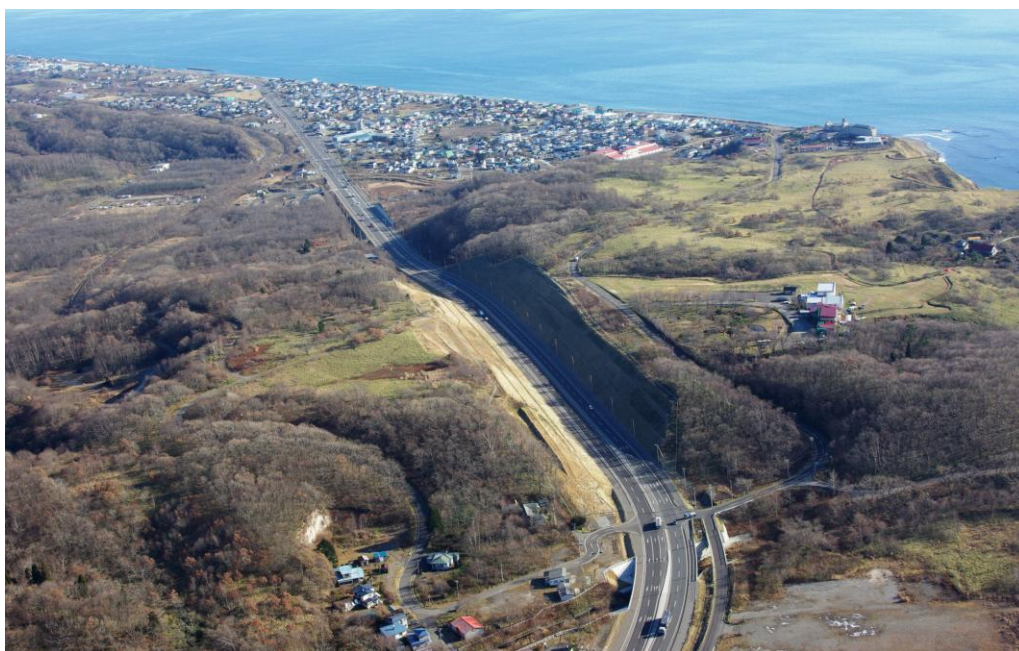
虎杖浜トンネルがオープンカットされた国道36号
